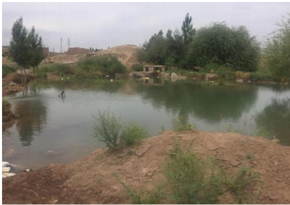
改造前节制分水闸
