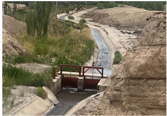
改造后节制分水闸
