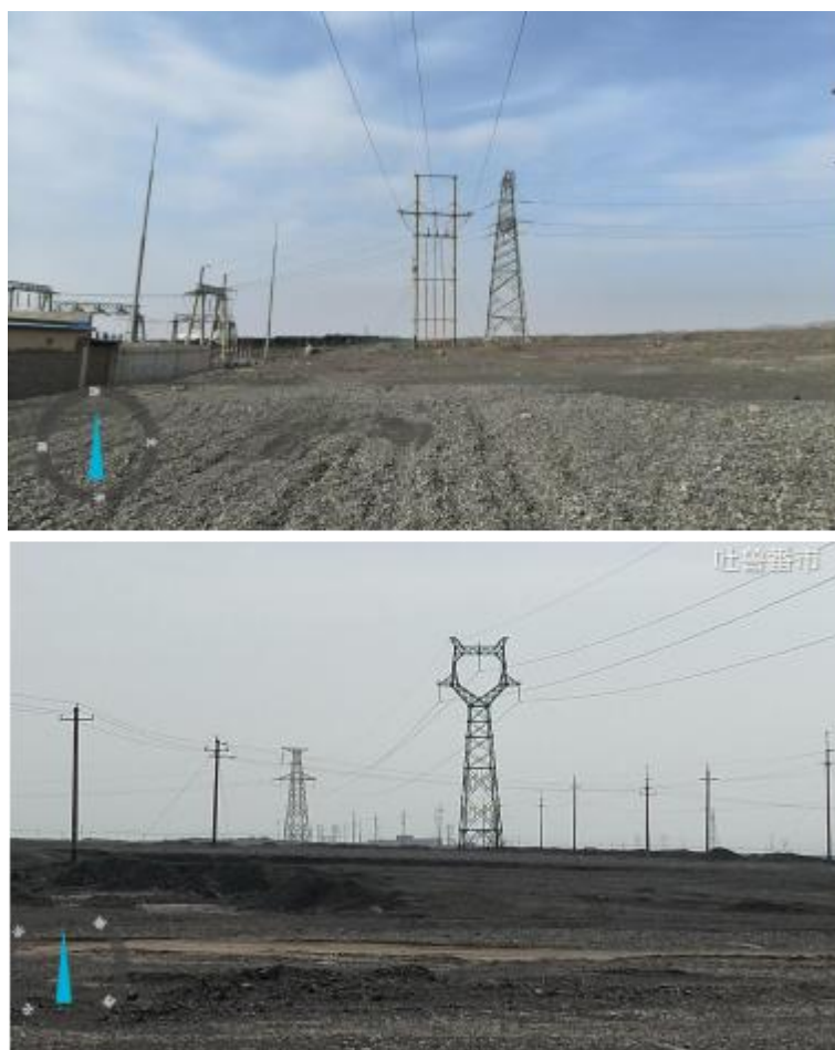
施工临时占地迹地恢复现场照片
